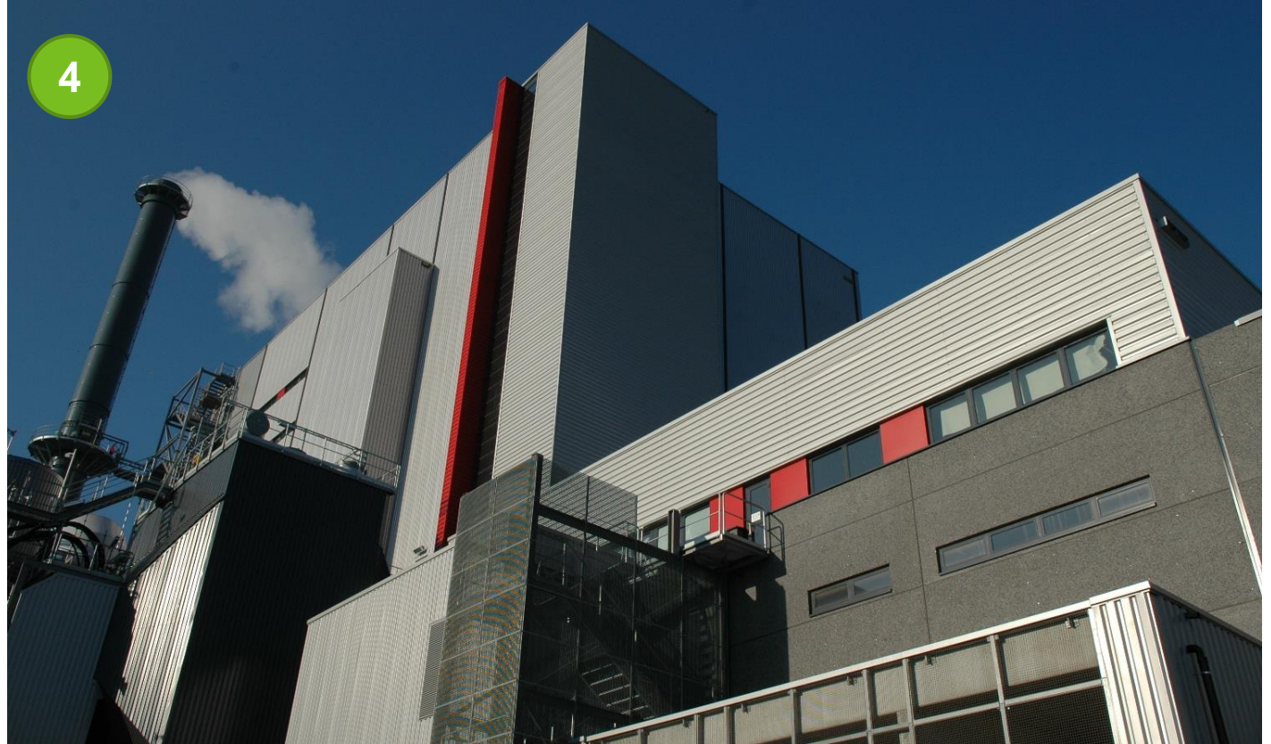
Centrale électrique 2, Langerbrugge Mill
